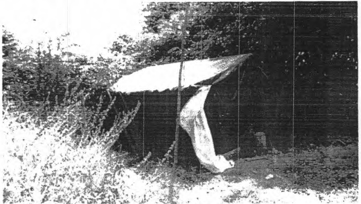
Imagem 01 – Barraco de lona sem janelas
