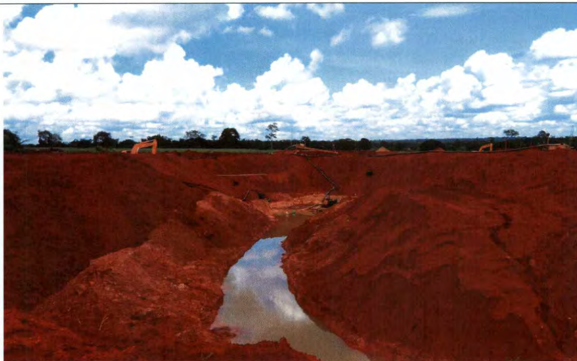
Imagem 6 – Fotografia panorâmica da frente de trabalho
